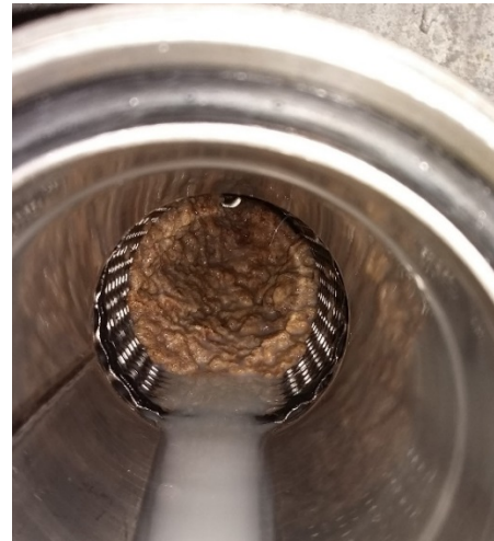
Abbildung 14 - Plattenbruch in Wendegruppe mit Produktabsetzung
